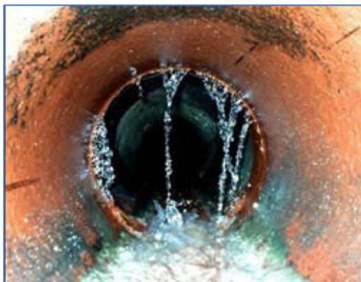
*Eau de ruissellement pénétrant dans le réseau d'égouts par un trou d'homme, à gauche, et par un défaut à l'intérieur d'un tuyau, à droite.*
